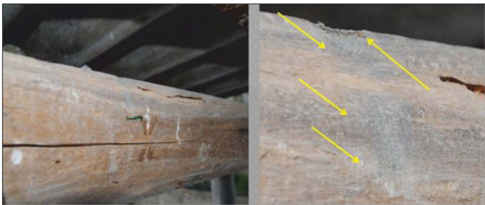
Fotografía n° 23. Se marca la orientación de las fibras en la cara opuesta del soporte.
