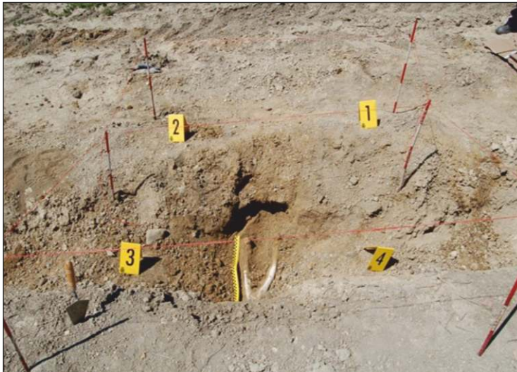
Fotografía nº 7. Sectorización de la zona a excavar.
