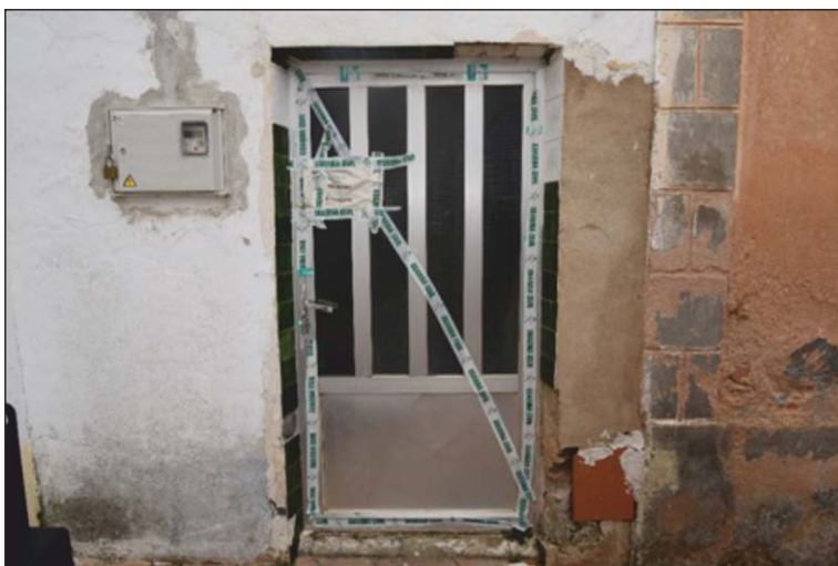
FOTOGRAFÍA 21: Fotografía de la puerta precintada de una vivienda inspeccionada.
